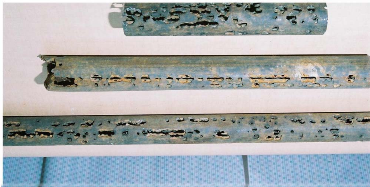
Рисунок Вид коррозионных разрушений фрагмента НКТ извлеченной из скважины 260 X горизонта месторождения «Гюнешли»
