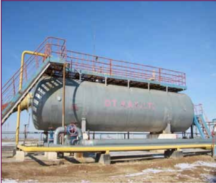
Трехфазный нефтегазовый сепаратор
