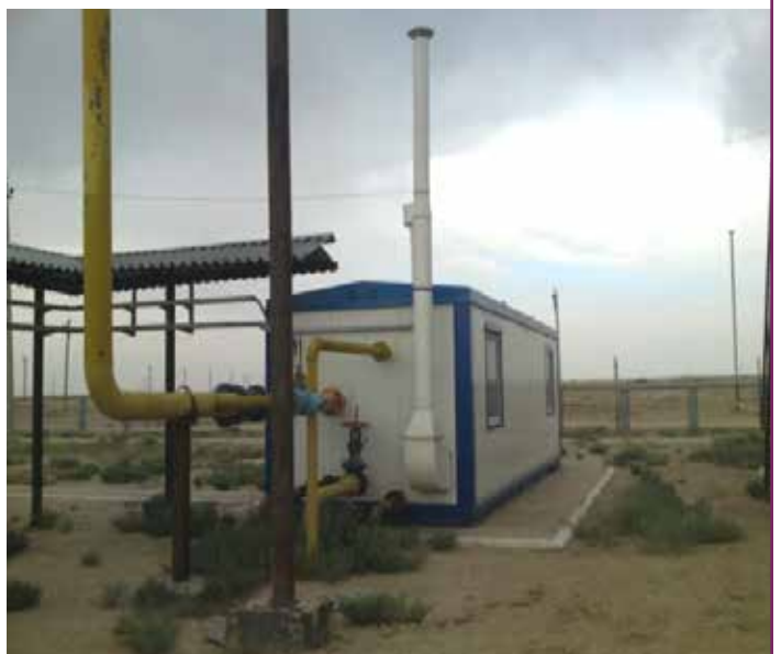
Сепарационный измерительный блок газа
