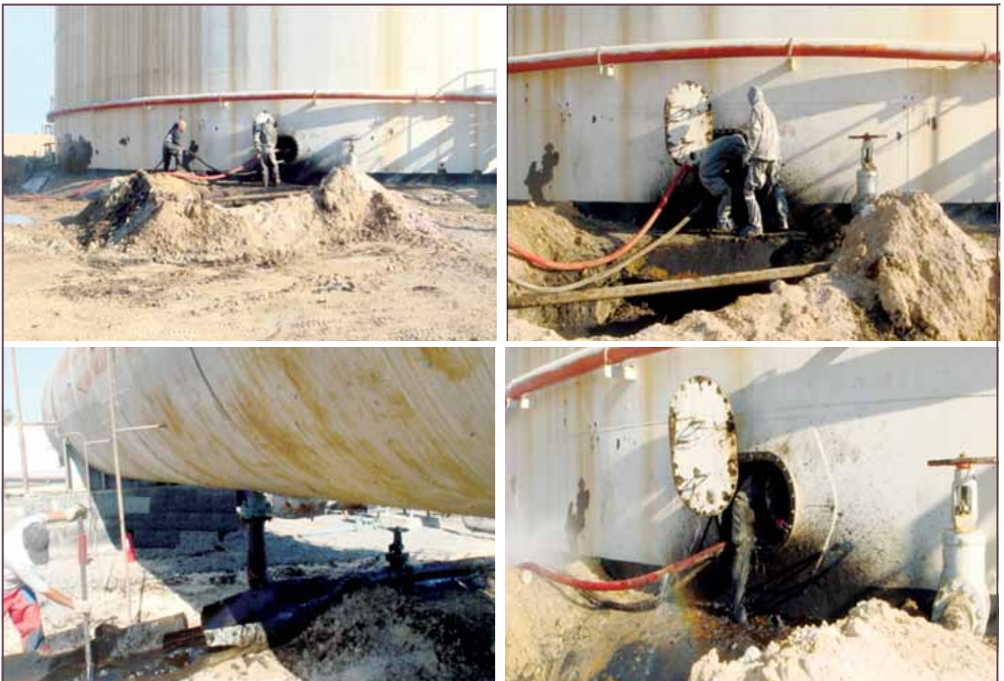
Рис.8. Очистка отстойников рабочим персоналом (ручная очистка)
