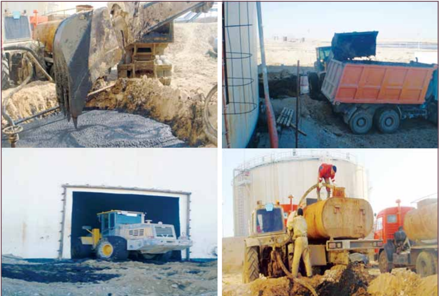
Рис.7. Очистка отстойников с применением спецтехники
