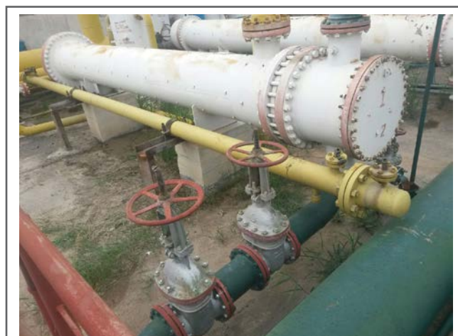
Рис. 2. Газодинамический сепаратор
